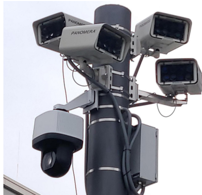
Mast mit verschiedenen Überwachungskameras (CC-BY thee@koeln.ccc.de)
